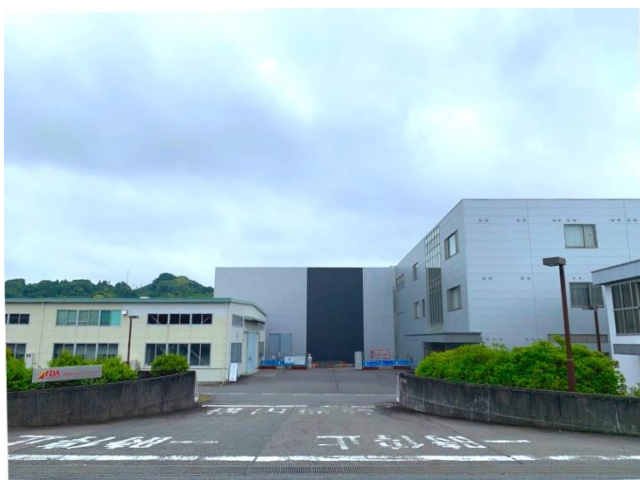
シミュレータ棟全景写真
